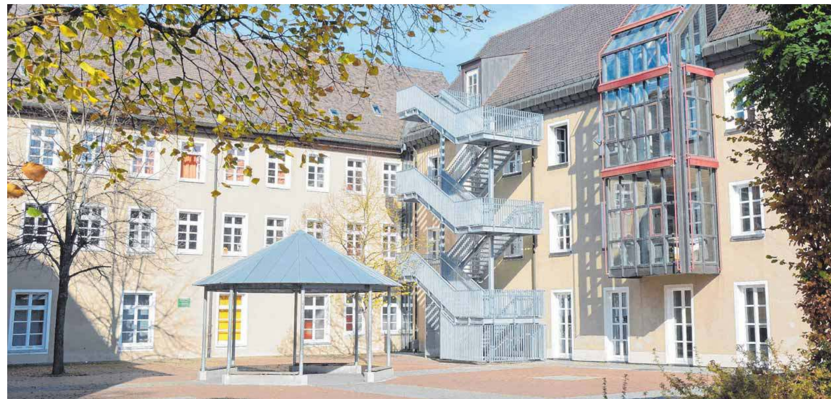
Ein Architektenwettbewerb wird für die Generalsanierung des Gymnasiums ausgelobt.
