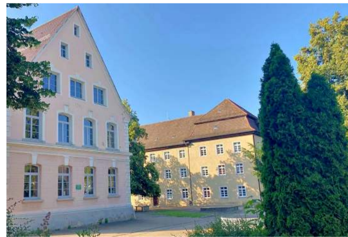
Die Planer schlagen vor, die Klosterscheuer (im Vordergrund) als erstes zu sanieren.
